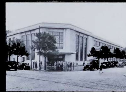
Établie à l'angle du boulevard de Vaugirard, la nouvelle gare est prévue pour s'étendre plus tard le long de l'avenue du Maine.
