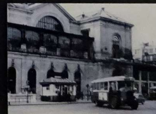
L'Opération Maine-Montparnasse est en cours d'exécution. La gare Montparnasse ferme ses portes le 26 septembre 1965.
