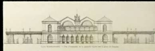
1898. L'augmentation du trafic voyageurs amène la Compagnie de l'Ouest à remanier en profondeur la gare Montparnasse.
