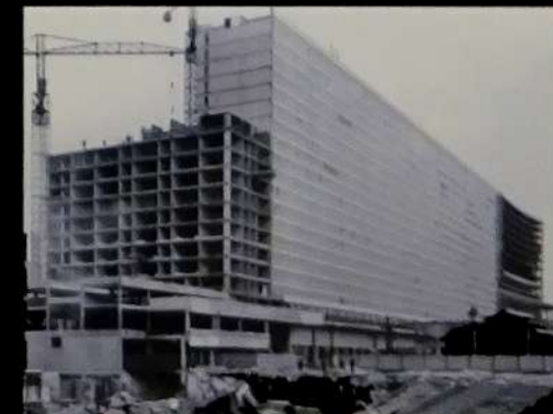
Mai 1966. L'immeuble Mouchotte (secteur 2) est en cours de construction. La gare Maine-Départ a été rasée.
