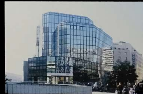
Montparnasse-Vaugirard sera édifiée par la SNCF en même temps que naîtra la place des Cinq-Martyrs-du-Lycée-Buffon.
