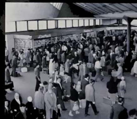
Le hall d'accueil de la gare Maine-Départ en 1958. La buvette et les espaces de vente de livres, journaux et tabacs sont resserrés.
