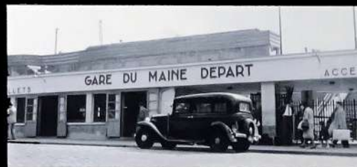
L'entrée de la gare Maine-Départ. La perspective d'une nouvelle gare Montparnasse a dicté la modestie des installations.
