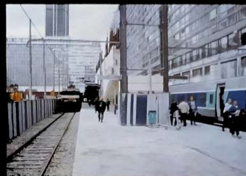
Durant les travaux de couverture des voies, le trafic voyageurs ne sera pas interrompu. Les premières arcatures sont en place.
