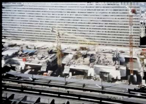
1990. Au pied de l'immeuble Air France, la première tranche est en chantier. Le parking Effia (SNCF) est visible sous la dalle.
