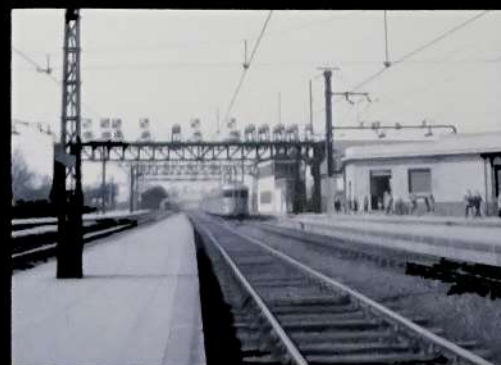
1950. Vue du pont sur l'avenue du Maine, la gare Maine-Arrivée borde les voies de banlieue qui mènent vers l'ancienne gare.
