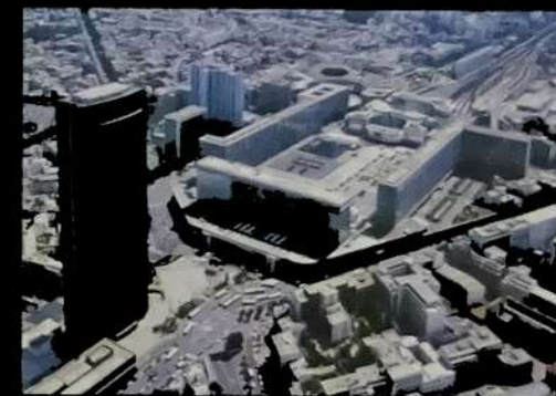
En juillet 1991, la dalle couvrant les voies est achevée et les trois bâtiments de l'architecte Jean Willerval sont réalisés.
