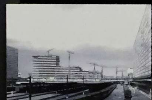
1965. Vue d'ensemble des quais de la nouvelle gare Montparnasse. Le bâtiment ouvrant place Raoul-Dautry (Secteur 4) sort de terre.
