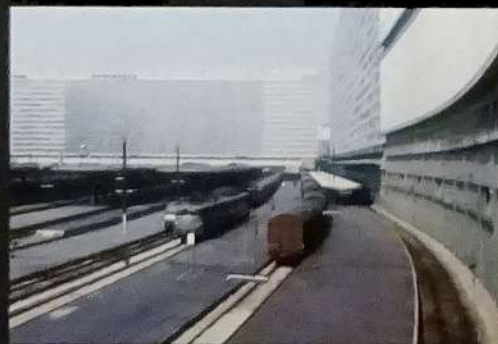
Sous les fenêtres de l'immeuble Mouchotte et au niveau des caves et des parkings, les deux voies dédiées aux bagages de la Sécra.
