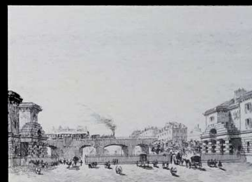
Les bâtiments de l'octroi à la barrière du Maine seront en fonction jusqu'en 1860.
