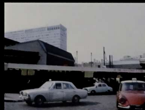
Le secteur 1 de l'Opération Maine-Montparnasse est achevé. La gare Maine-Départ fermera à son tour le 26 septembre 1965.
