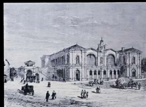
La gare Montparnasse en bordure du boulevard Montparnasse et de la rue du Départ vers 1876.
