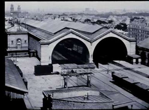
Vue sur les quais de la gare Montparnasse. Le nombre des voies a été doublé et un pont transbordeur facilite les manœuvres.
