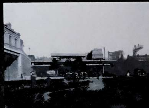
Le viaduc métallique qui double en largeur le pont en pierre de 1851 isole un peu plus le boulevard Edgar-Quinet et l'avenue du Maine.
