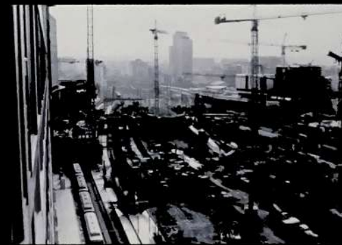
La seconde tranche du chantier s'ouvrira, au pied de l'immeuble Mouchotte. Le trafic a été basculé sous la première travée.
