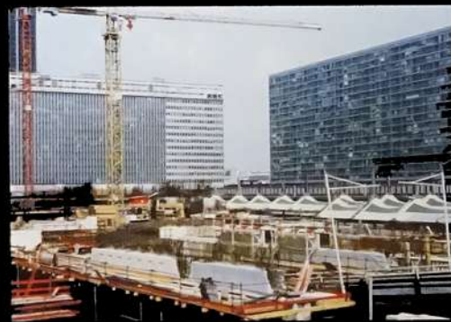
Début 1991, la partie nord-ouest du chantier s'achève. La vue est prise du pont des Cinq-Martyrs-du-Lycée-Buffon.
