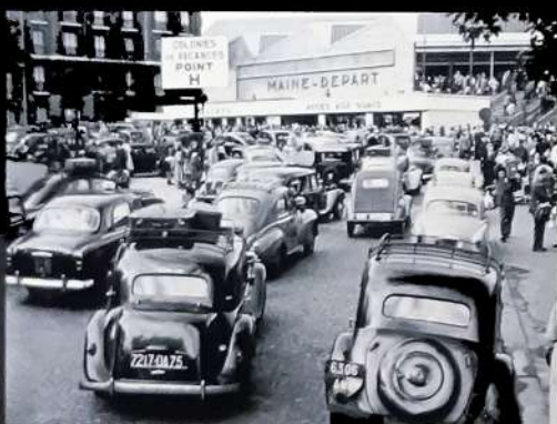
La motorisation croissante de la fin des années 1950 se traduira vite par une insuffisance des aires de dépôt des voyageurs.
