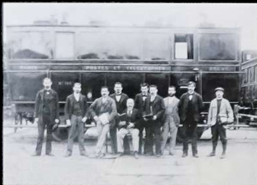
Tri postal. Vers 1900, la brigade de Paris pose devant le Bureau ambulant (En service de Paris à Brest depuis 1874). (Archives de la SNCF)
