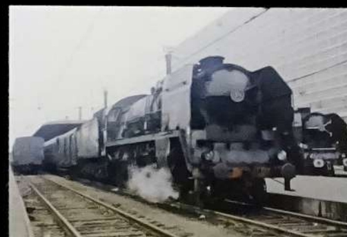
La traction vapeur, pour la ligne de Granville notamment, sera le quotidien des premiers habitants de l'immeuble Mouchotte.
