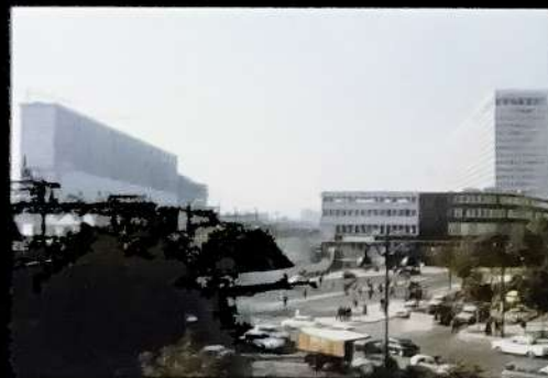
Après la barre du secteur 1 (1964) et celle en cours du secteur 2 (Mouchotte), celle de la nouvelle gare est amorcée.
