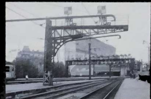
1965. En bordure des voies, la barrière principale de l'immeuble Mouchotte sort de terre. Celle de l'escalier A suivra en 1966.
