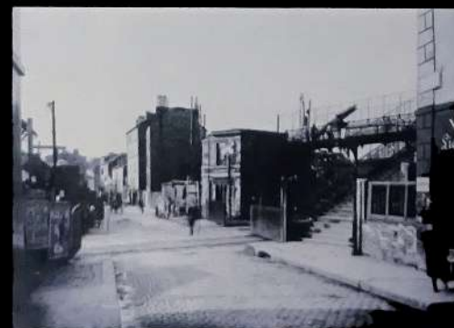
Passage à niveau de la rue du Château. L'accroissement du trafic a obligé la création d'une passerelle pour les piétons.
